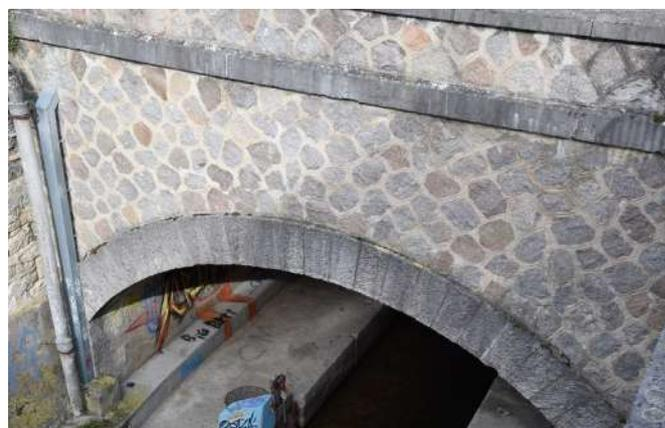
**Figure 1** : Le granite carbonifère du Beaujolais des crus (ou granite d'Odenas-Fleurie), dans une maçonnerie à l'entrée ouest du tunnel sur le Morgon (début XXe), place du 11 Novembre.
